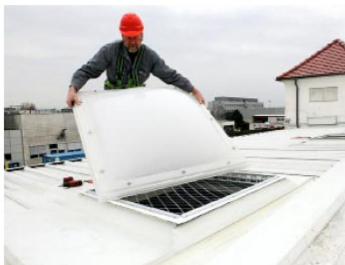
Befestigung auf nahezu allen intakten Aufsatzkränzen möglich. Likunet® wird in den Aufsatzkranz eingelegt und mit den mitgelieferten Schrauben befestigt. Bei Lüftungsmotoren kann das Gitter in kleinen Bereichen
