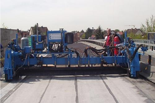
für den maschinellen Einbau von Gussasphalt im Straßen- und Hallenbau
